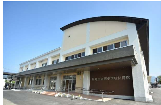
西中学校多機能型体育館
