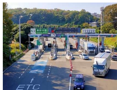
秦野中井インターチェンジ
