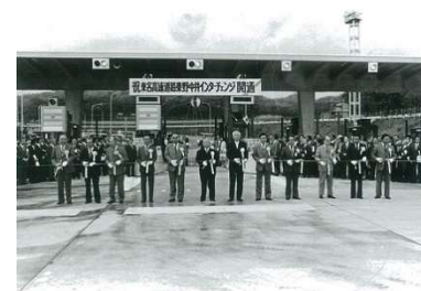
秦野中井インターチェンジ完成
