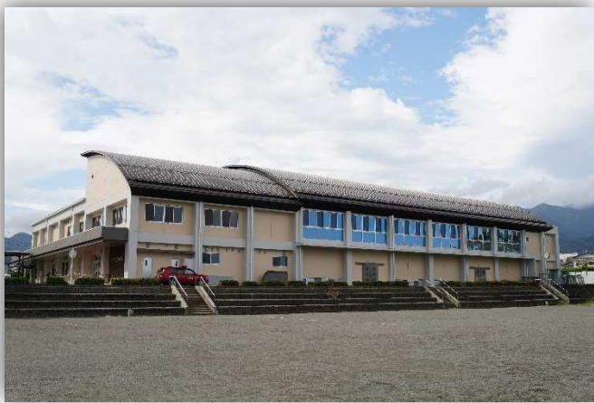
西中学校多機能型体育館
