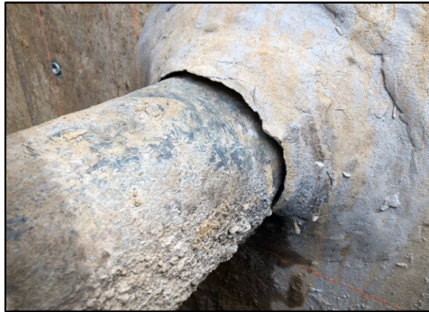
図 3-4 ボックスカルバート貫通部分
