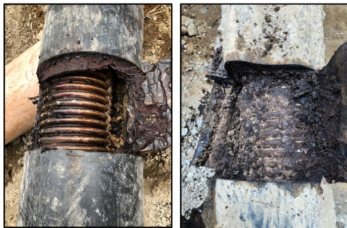
図 3-6 高温水配管の保温材の状況
