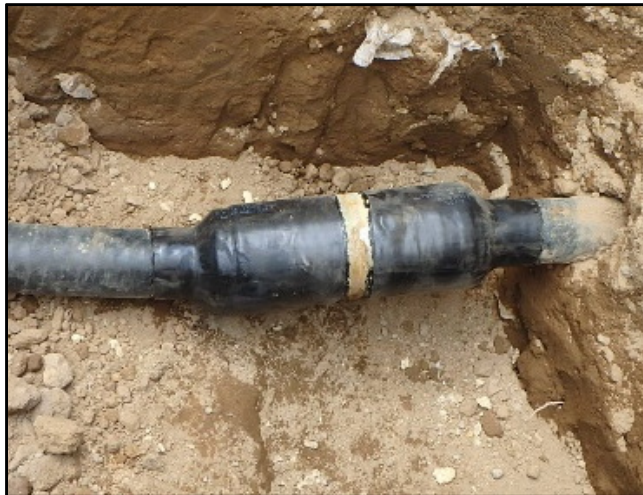
図 7-2 富士見の湯側土中埋設部分の溶接箇所
