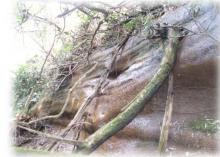
写真：法面の浸食状況
