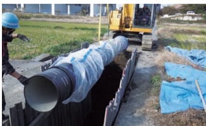
管路耐震化の現場
