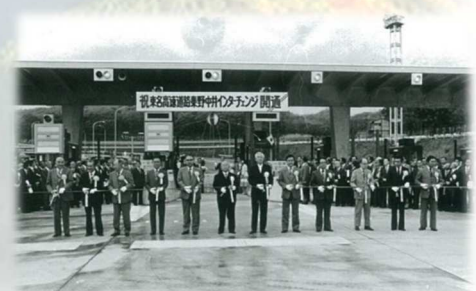
東名高速道路 秦野中井インターチェンジ完成
