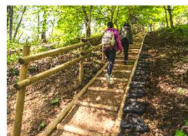
ウッドチップ舗装・階段
