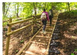
ウッドチップ舗装・階段
